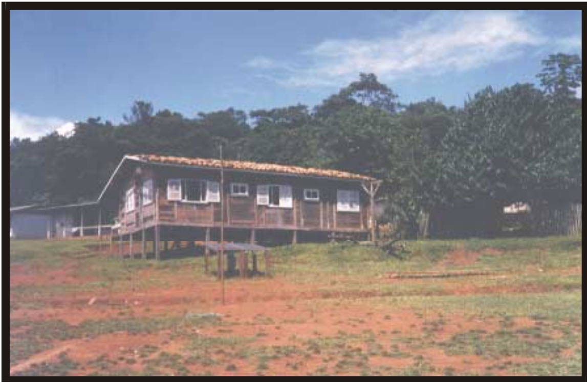
Foto 09 - Vista do Posto de Saúde do Distrito de Água Branca do Cajari.
