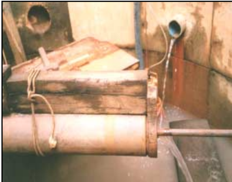
Foto 12 - Operação de retirada dos tubos de 6 5/8" com sistema de escoramento dos filtros por tubo de 1"
