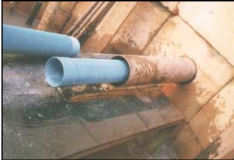
Foto 11 - Colocação de filtros em PVC rígido de 4"
