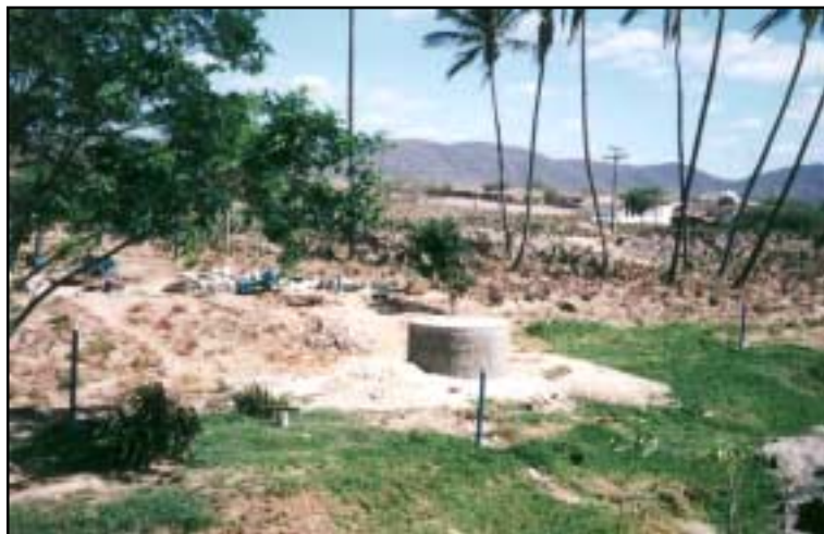
Foto 18 – Marcação em superfície da projeção dos três drenos instalados
