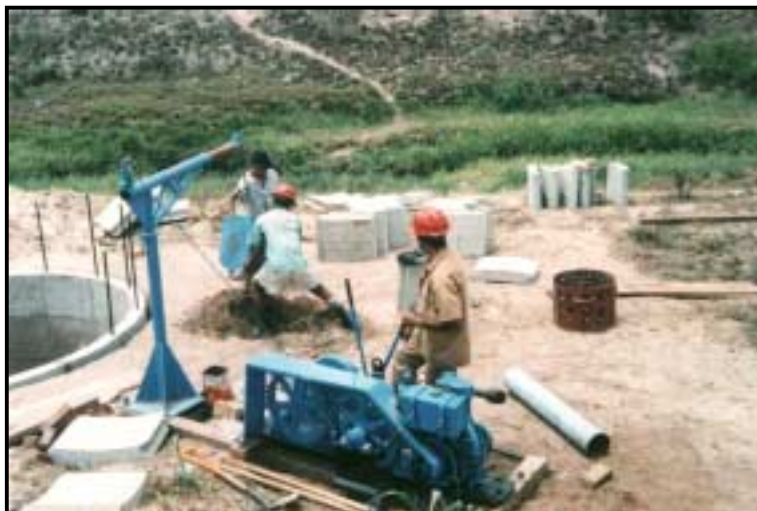
Foto 23 - Guincho com estrutura telescópica utilizados na extração de material de desmonte
