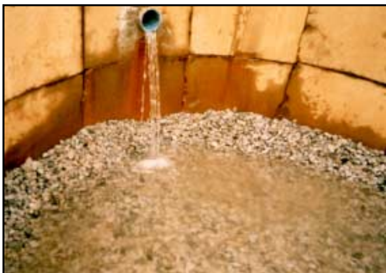
Foto 20 - Instalação de fundo com brita nº 19
