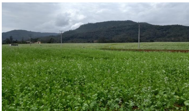
Processo de revegetação da porção central da área Rio Pio com objetivo de controle de erosão da cobertura argilosa construída sobre os estéreis da mineração.
