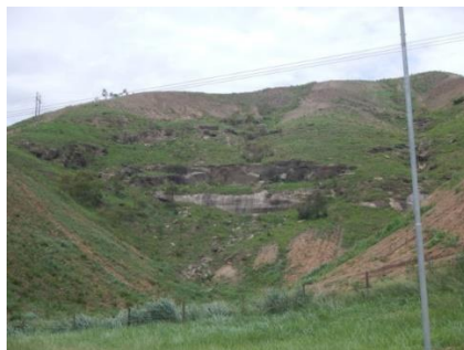
Encosta com suscetibilidade a quedas de blocos - Município de Vassouras- RJ
