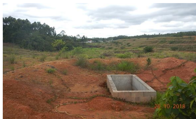
Cobertura de argila sobre os rejeitos e sistema de drenagem parcialmente executado
