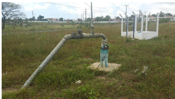
Par de poços utilizado para teste de Aquífero - P1-B (produtor) e PZ02 (piezômetro no cercado)
